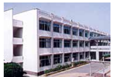
南覺舎(平成13年1月改修)
